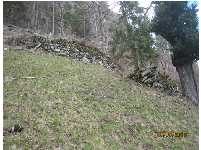
Fig. 20: Manufatti di sostegno del pendio delle FFS del periodo intorno all'anno 1900: sinistra gruppo di opere, destra opera singola. (Fonte: FFS AB, Ingenieurbau und Umwelt, Natur und Naturrisiken)
